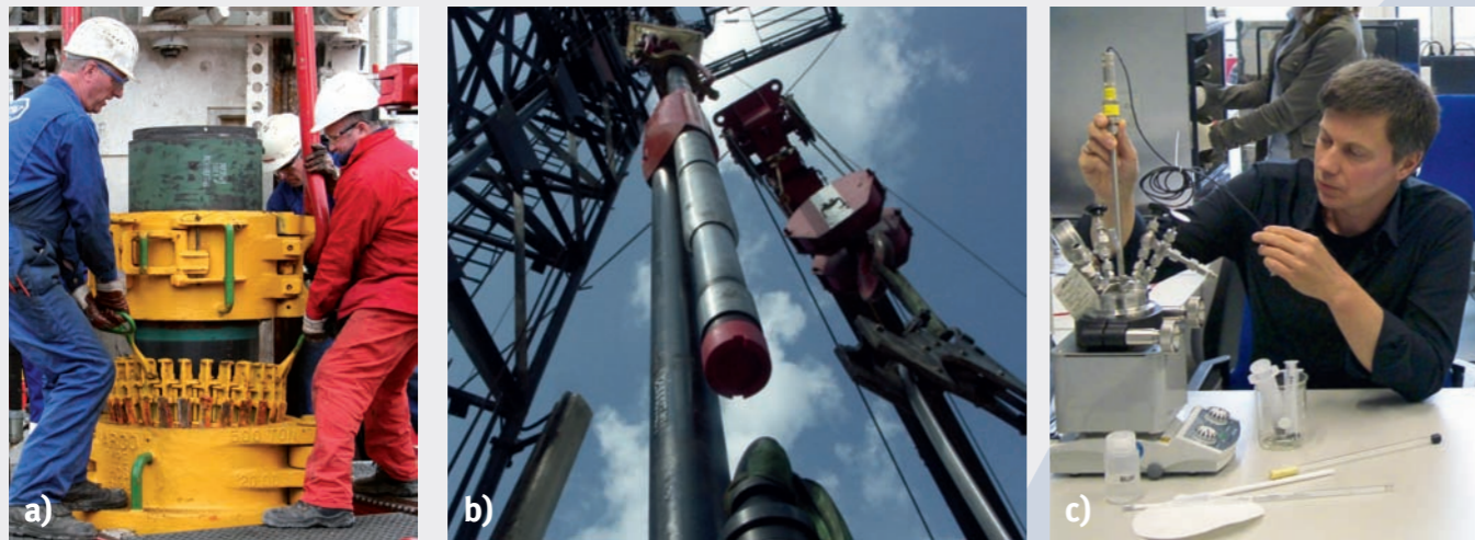
v.l.n.r.: a) Rohreinbau zur Sicherung der Bohrung; b) Einbau eines so genannten Y-Tools, das Bohrlochmessungen während der Thermalwasserproduktion ermöglicht; c) Thermophysikalische Fluidmessungen im Labor
